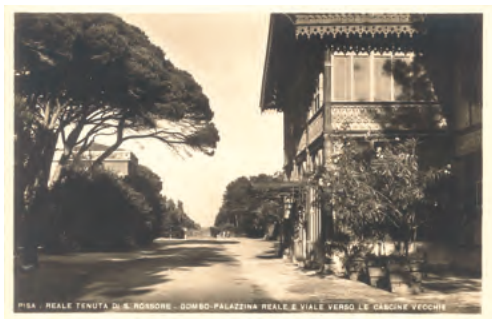
Fig. 12 - Il Real Casino del Gombo dopo le modifiche degli anni Trenta del Novecento. Nello stesso luogo fu edificata negli anni Cinquanta la villa presidenziale sopraelevata.
