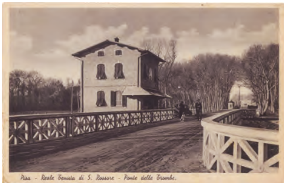
Fig. 9 - Il Ponte delle Trombe sul Fosso Cuccia, alla fine del Viale delle Cascine e ingresso principale della Tenuta.
