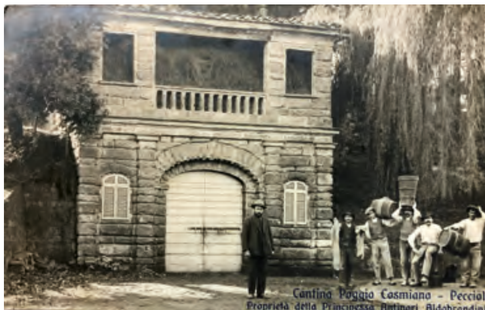
Fig. 30 - Villa Cosmiana, La cantina storica in una foto dei primi anni del XX secolo. È evidente come il primo piano venisse utilizzato come fienile-granaio (collezione Villa Cosmiana).
