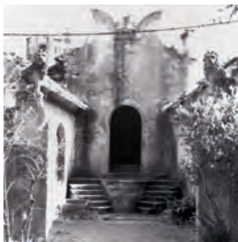
Fig. 43 - Villa Belvedere, l'ingresso al bagno «termale».
