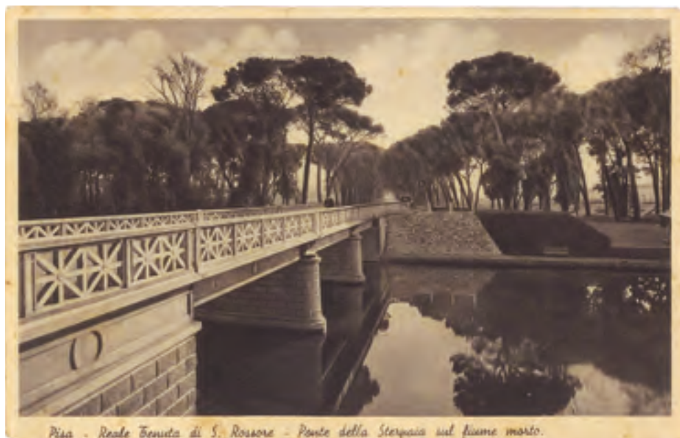
Fig. 8 - Il Ponte della Sterpaia sul Fiume Morto, costruito nel 1930 in cemento armato.
