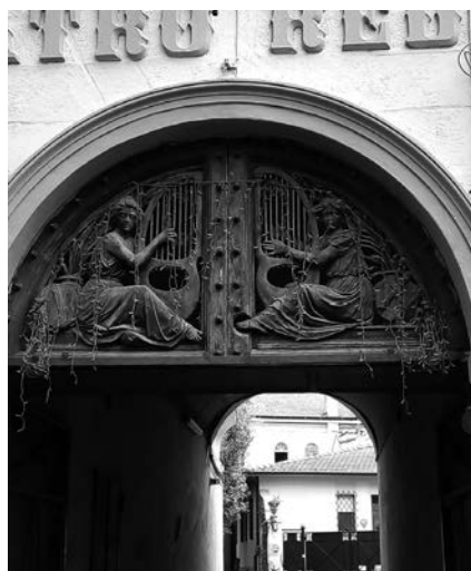
Particolare della rosta.
