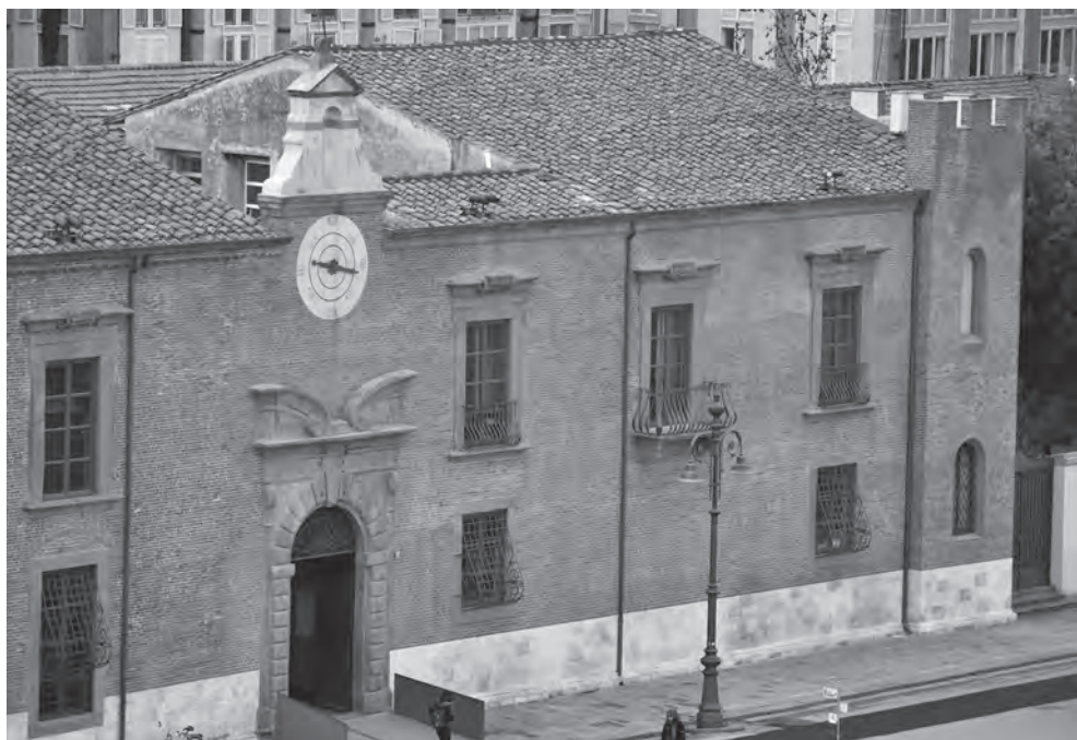
La facciata prima e dopo il restauro
